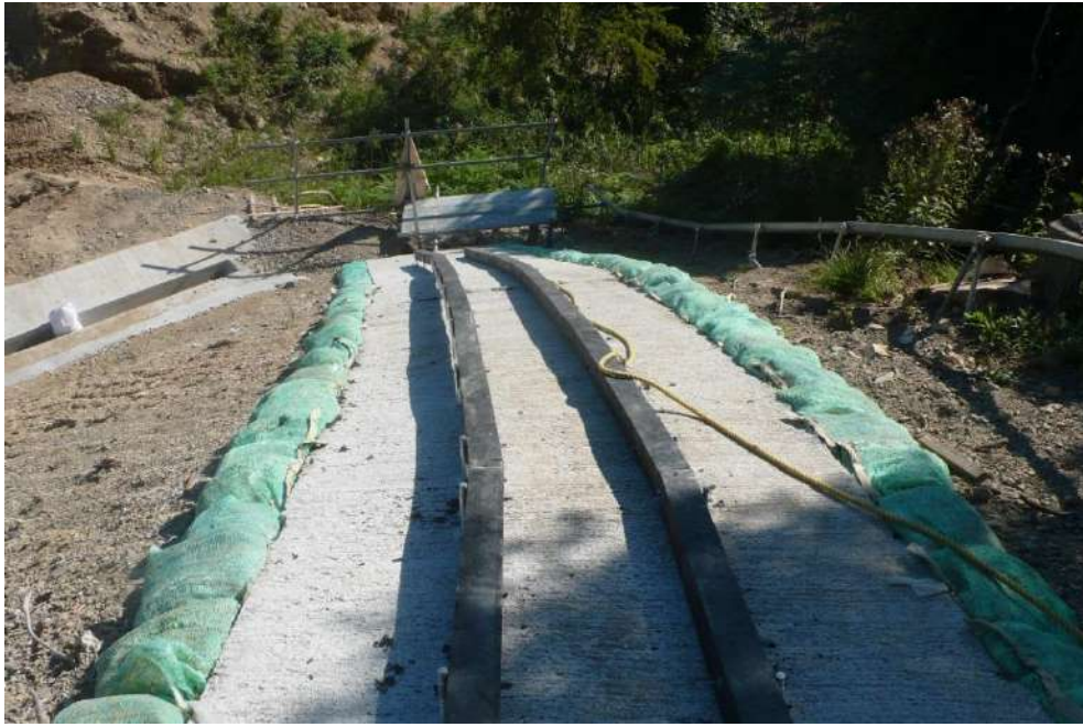
シールコンクリート面 特殊施工例
