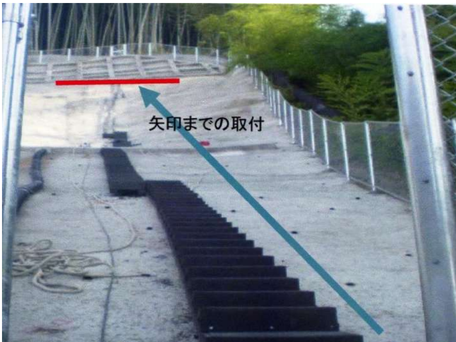
コンクリート吹き付け面取付
