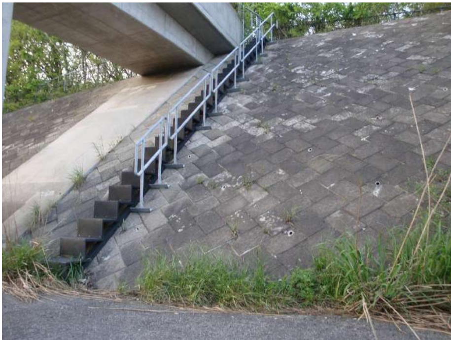
コンクリート面取付
