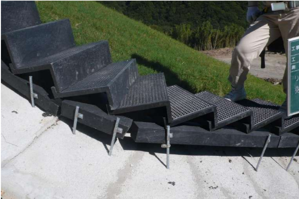
曲がり部 施工例
