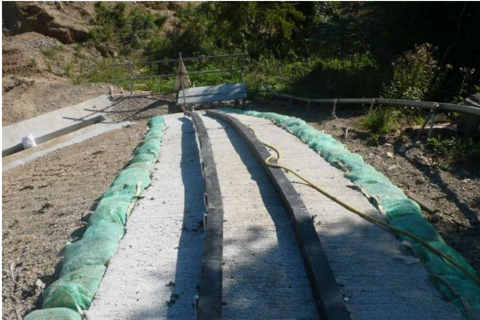
シールコンクリート面 特殊施工例
