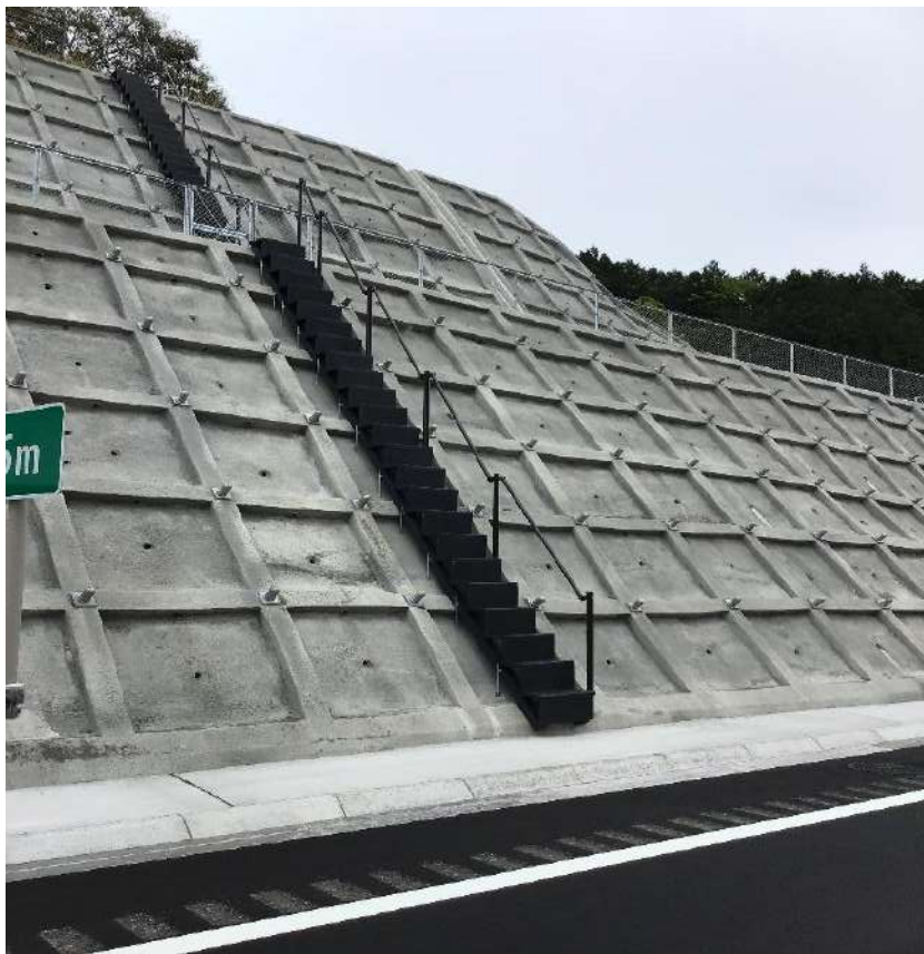
コンクリート法枠面 鉄筋杭使用
