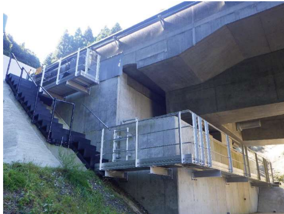
橋梁階段 (下地: シールコンクリート)
